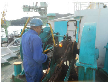
係船機の整備
