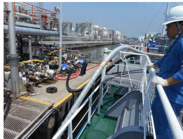
海に漏れていないか監視
